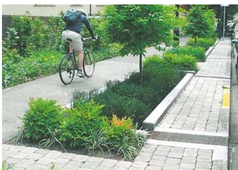
Noue végétalisée dans un trottoir
