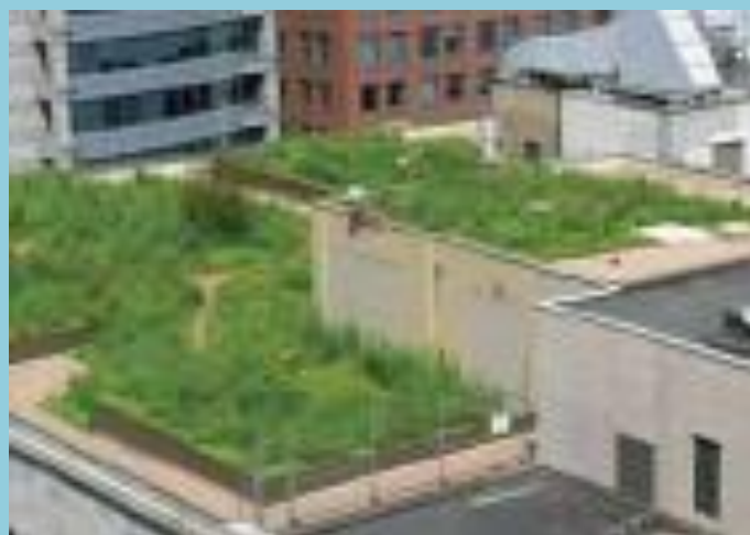
Grâce à l'évapotranspiration, la végétation, y compris sur le bâti, permet de réguler la température et l'hygrométrie locale et protège contre l'effet d'îlot de chaleur urbain. (Source : Report US EPA)
