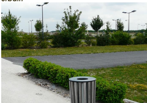
Aire de stationnement en mélange « terre-pierre »
